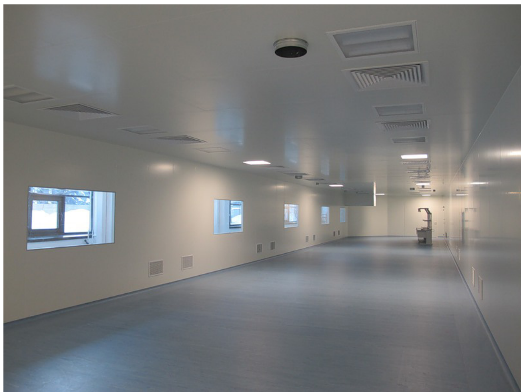
Системы кондиционирования для «чистых» помещений предприятий ОАО «Светлана», ОАО «ЛОМО». Проектирование прецизионных систем кондиционирования, поставка и монтаж оборудования. Общая производительность по холоду 0,8 МВт.
