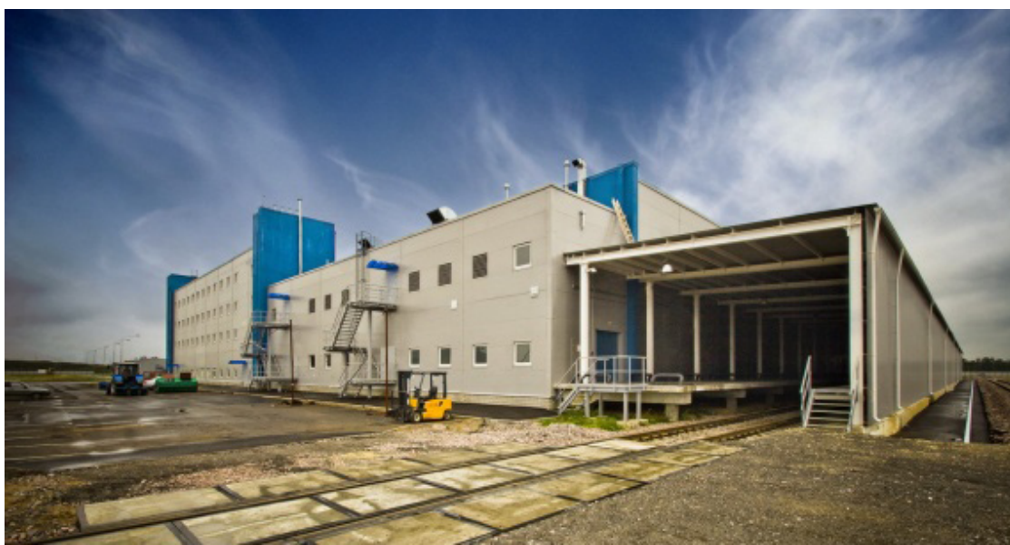
Логистический комплекс 1-й Контейнерной компании в п. Шушары. Проектирование, поставка оборудования и монтаж «под ключ» систем отопления, вентиляции и кондиционирования, ИТП.
