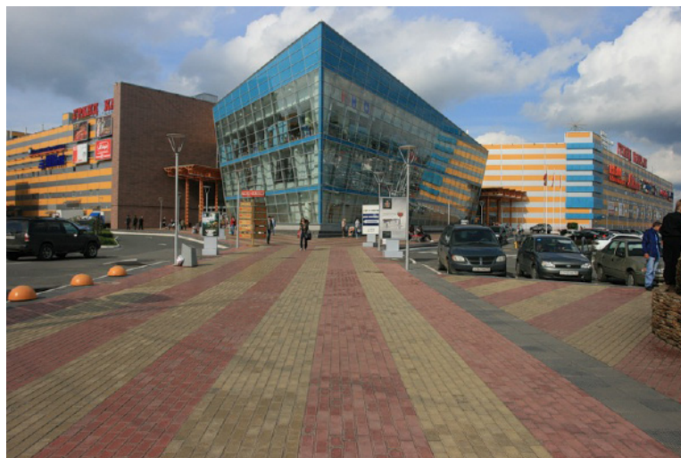
Абсорбционная холодильная станция и магистральное холодоснабжение ТРК «Гранд Каньон» – 7,5 МВт по холоду. Проектирование, поставка и монтаж систем холодоснабжения. Впервые в отрасли были применены полимерные трубопроводы на всей системе холодоснабжения!
