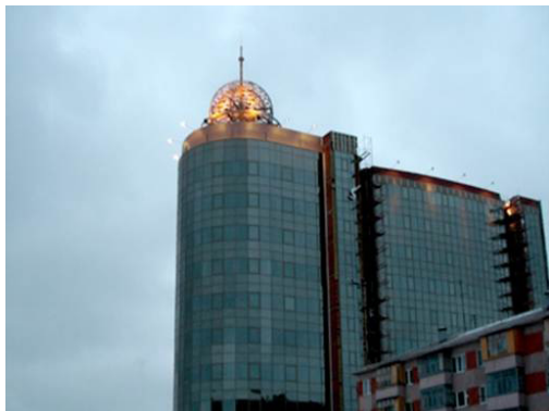
Системы кондиционирования и вентиляции в офисных зданиях ОАО «Сургутнефтегаз» (г. Сургут) — 12400 кв.м. Рабочее проектирование, поставка оборудования и монтаж «под ключ».
