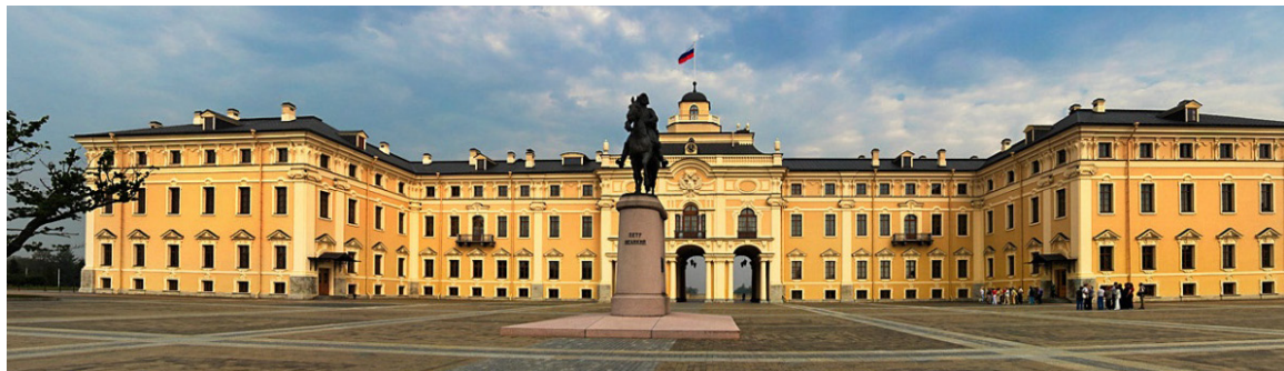
Константиновский дворец (морская резиденция). Монтаж центральных кондиционеров в левом крыле дворца, монтаж систем вентиляции в АБК.
