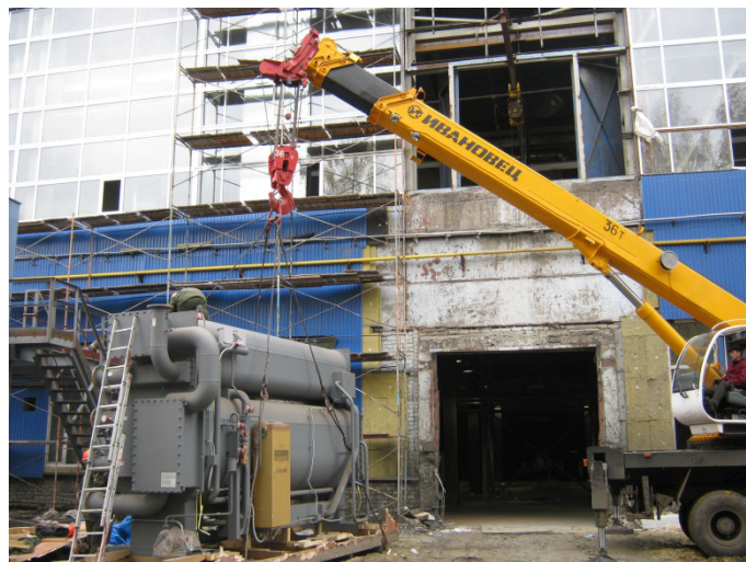
Абсорбционная холодильная станция и ОАО «ВКМ-Сталь» (г. Саранск), производительность по холоду – 8,5 МВт непрерывного цикла. Проектирование, поставка и монтаж оборудования «под ключ».
